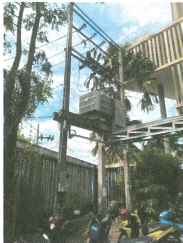
รูปภาพที่ 2.27 หม้อแปลงไฟฟ้า
